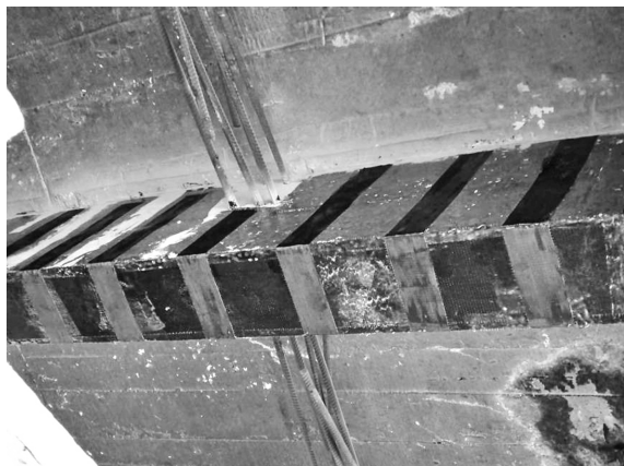
图4 混凝土构件碳纤维布加固
